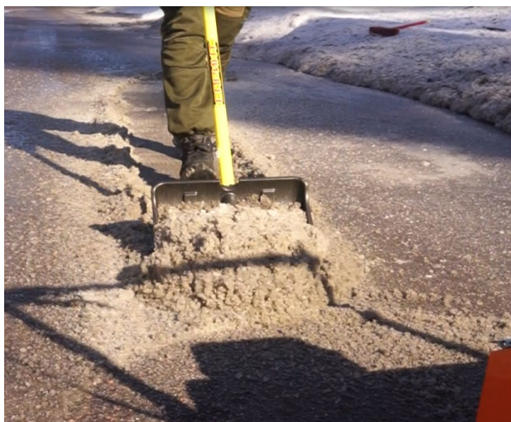
Рис.7. Очистка поверхности от ледяной крошки.
